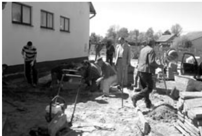
Układanie chodnika obok remizy.
