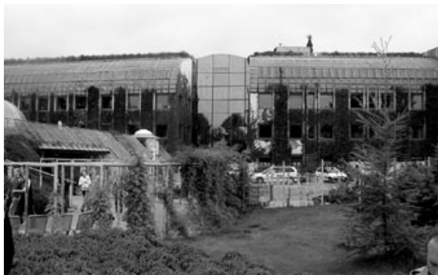
Nowoczesny gmach Biblioteki Uniwersytetu Warszawskiego z pięknymi ogrodami na dachu.
