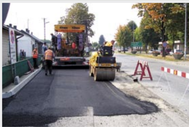
Asfaltowanie parkingu po południowej stronie Rynku.
