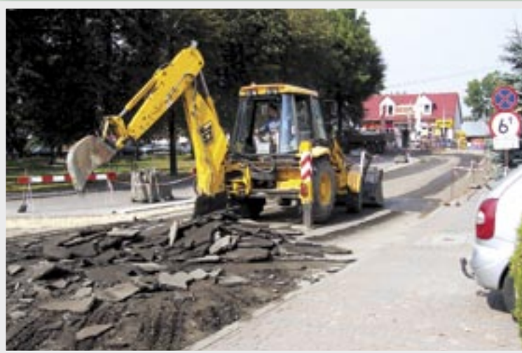
Zrywanie starej nawierzchni drogowej.
