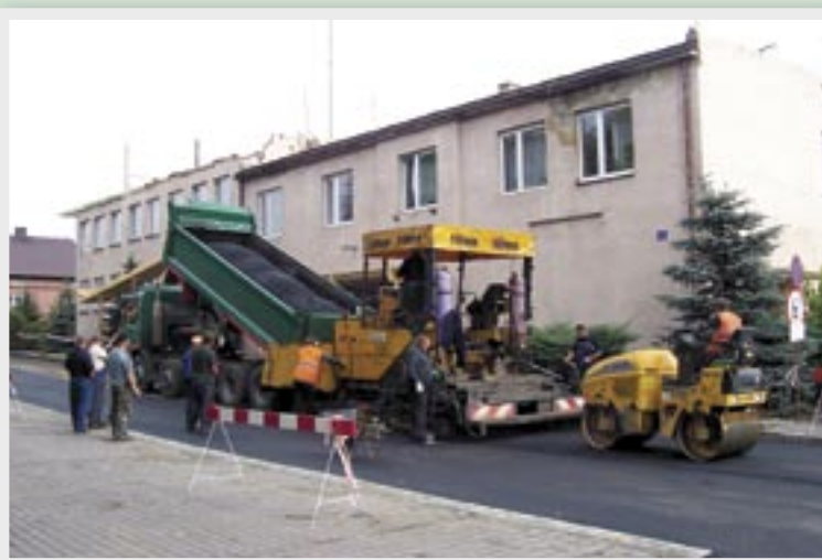
Asfaltowanie ulicy przy Urzędzie Gminy.
