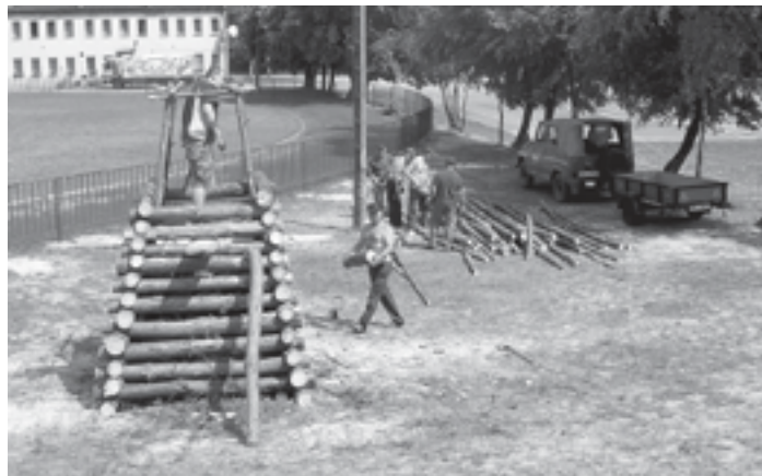
Budowa sobótkowej konstrukcji przez strażaków z OSP Raniżów.
