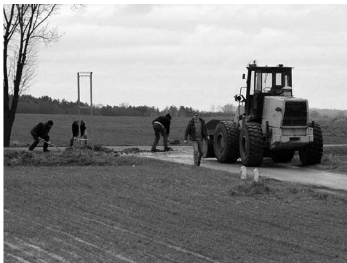
Bieżące remonty gminnych dróg żwirowych. Fot. St. Samojedny
