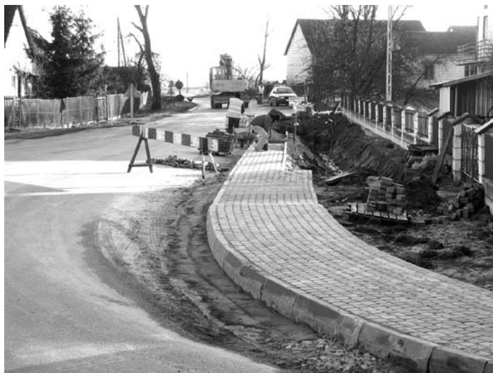
Układanie chodnika obok posesji p. Kwaśnika i p. Krawca.
