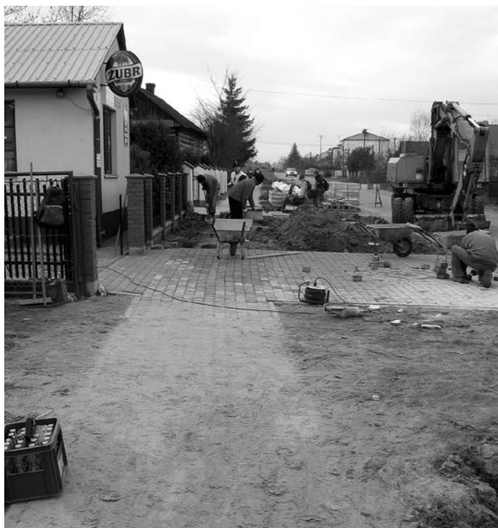
Prace na wysokości sklepu p. Prusia.
