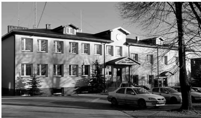
Budynek Urzędu Gminy w Raniżowie po modernizacji.
