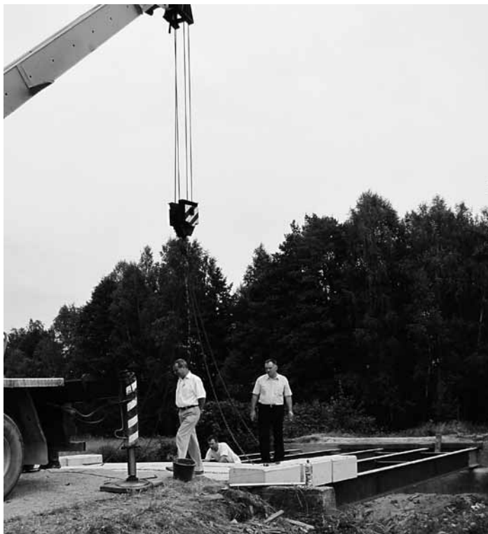
5 sierpnia 2009 r. Wójt Jan Niemczyk i sekretarz gminy Marek Margański przy układaniu nowych żelbetonowych płyt mostowych.
