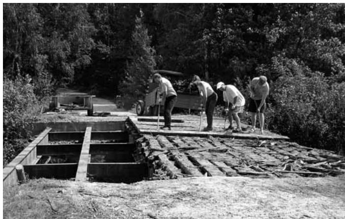
22 lipca 2009 r. Usuwanie zniszczonych, drewnianych elementów mostu.
