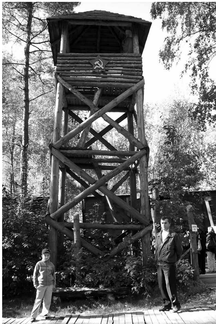
Obozowa wieża strażnicza zrekonstruowana w skansenie budownictwa drewnianego w Szymbarku, woj. pomorskie. Fot. St. Samojedny.
