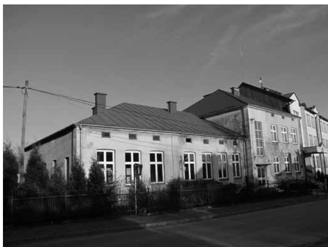
Grudzień 2008 r. Widok na najstarszą część budynku szkoły, którego powstanie datowane jest na koniec XIX w.
