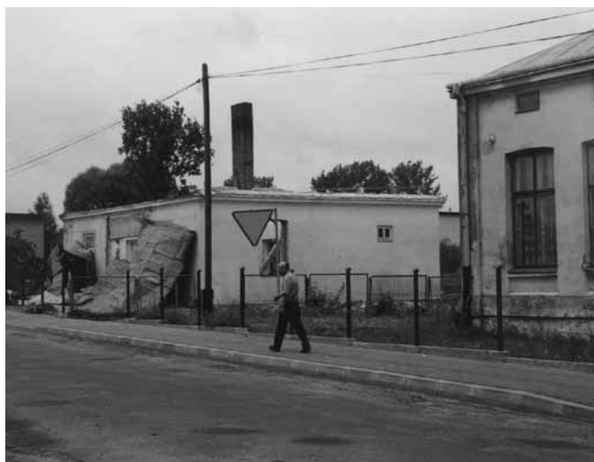
Sierpień 2001 r. Rozpoczęła się rozbiórka budynku mieszkalnego kierownika szkoły.
