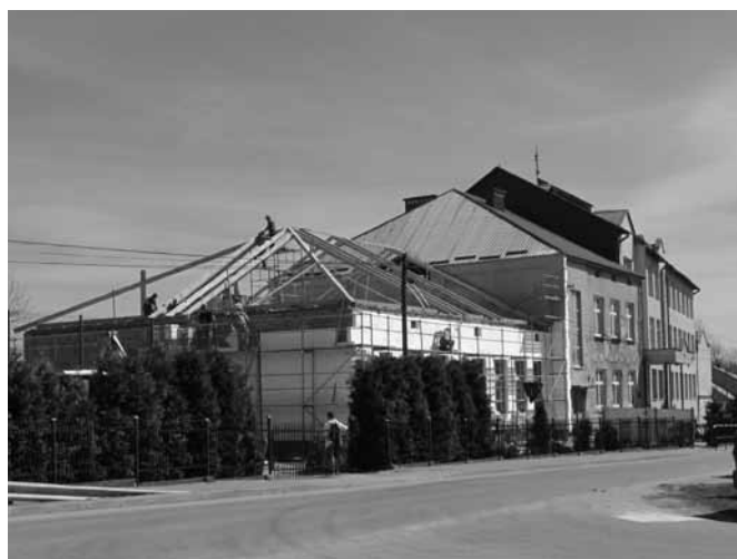
Kwiecień 2010 r. Prace remontowe przy wymianie dachu oraz nowej elewacji.
