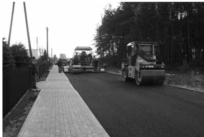
Asfaltowanie ul. Św. Floriana w Raniżowie.
