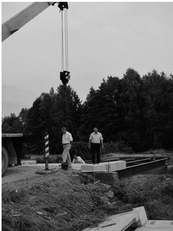
Przebudowa mostu na rzece Turce w Mazurach.
