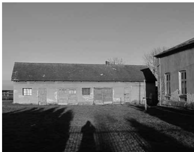
Grudzień 2008 r. Na przyszłym boisku szkolnym stoi jeszcze budynek gospodarczy należący niegdyś do gospodarstwa kierownika szkoły.
