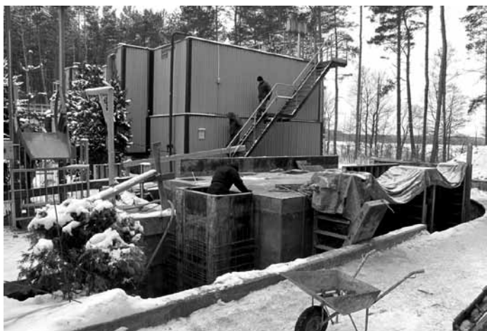
Budowa zbiornika uśredniająco-retencyjnego z sitopiaskownikiem.
