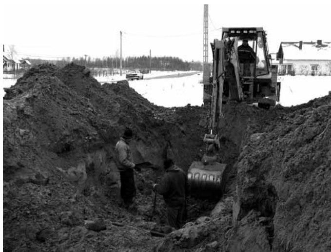
Prace przy kanalizacji przy ul. Sokółowskiej w Ranżowie.
