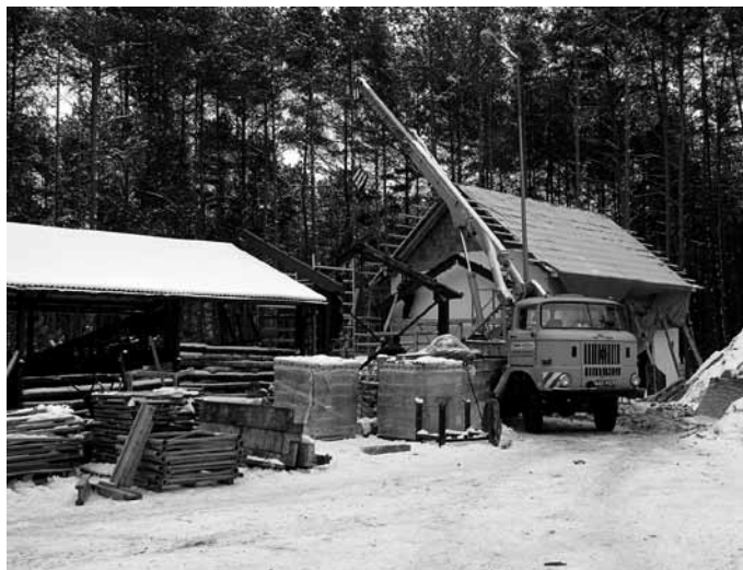
Budowa stacji odwadniania na oczyszczalni.
