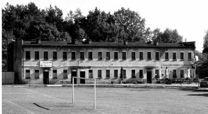
Budynek przed remontem...
