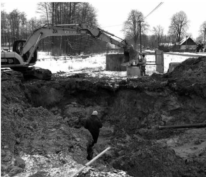
Wykopy pod kanalizację w Staniszewskim obok Domu Ludowego.
