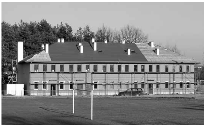
...w trakcie remontu...
