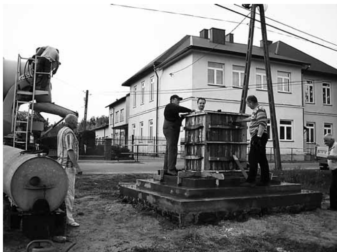
Wykonywanie betonowego cokołu i stopni pod pomnik.
