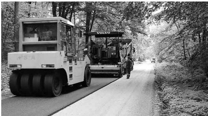
Praca przy asfaltowaniu obok p. Rodzenia.
