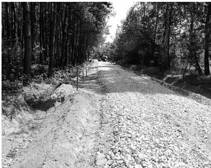
Widok remontowanej drogi łączącej Poręby Wolskie ze Stecami.
