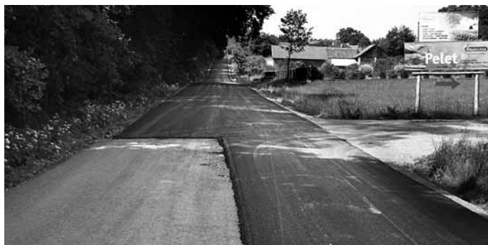
Pierwsza warstwa asfaltu obok p. Wosia.
