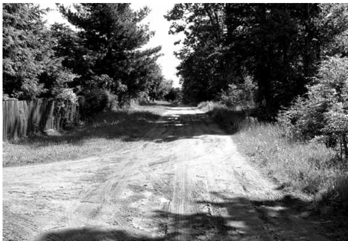
Wygląd drogi przed rozpoczęciem modernizacji...
