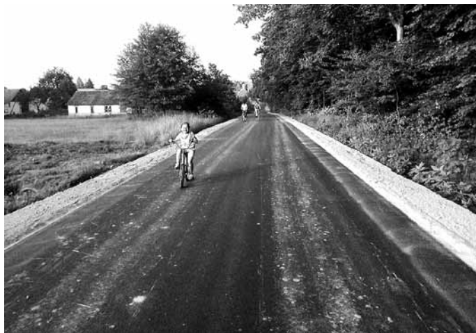
...i nowa nawierzchnia po oddaniu do użytku.
