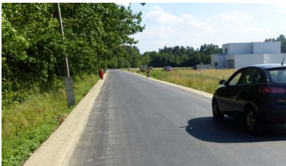
Przebudowana droga powiatowa w Dzikowcu.
