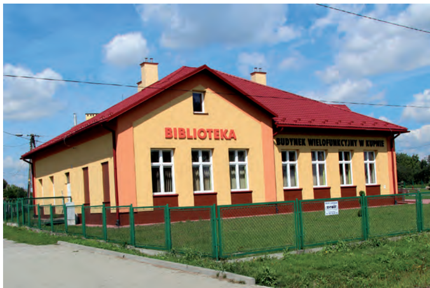
Biblioteka – budynek wielofunkcyjny
