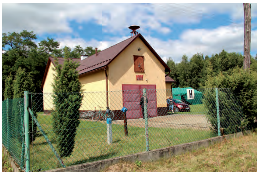
Nowo wybudowany budynek Ochotniczej Straży Pożarnej (OSP)
