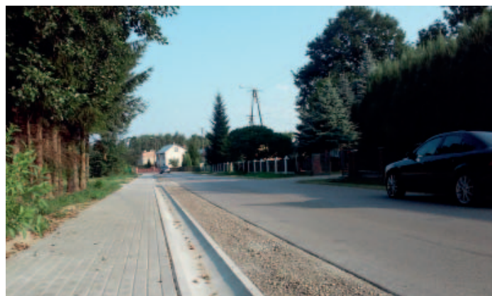
W ramach Narodowego Programu Przebudowy Dróg Lokalnych - Etap II - Bezpieczeństwo - Dostępność - Rozwój - 2012 - 2015 w gminie Dzikowiec powstały cztery odcinki dróg powiatowych.
