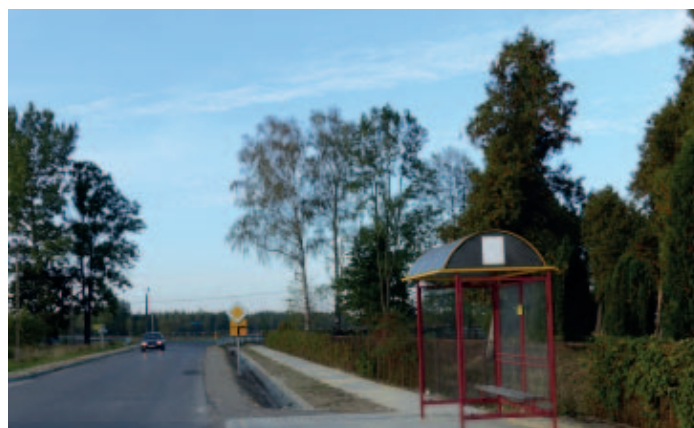
Nowo wybudowany chodnik w centrum Dzikowca.
