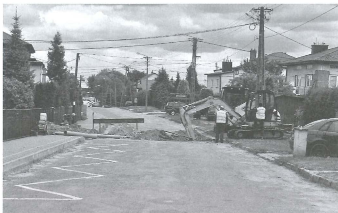
Przebudowa kanalizacji na ul. 22 lipca
