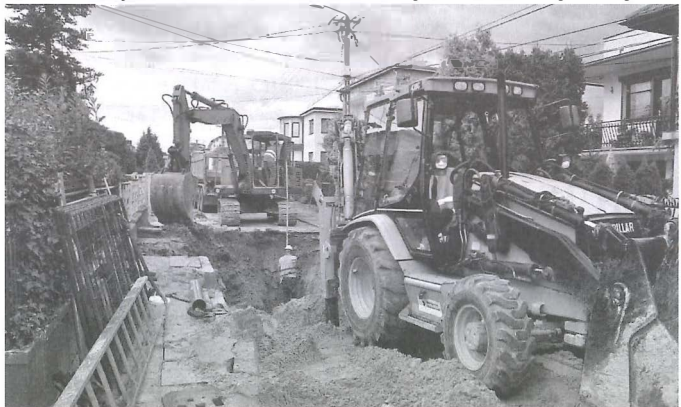
Przebudowa kanalizacji na ul. Wojska Polskiego
