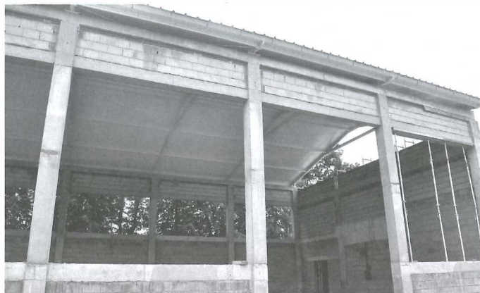
Budowa sali gimnastycznej w Weryni
