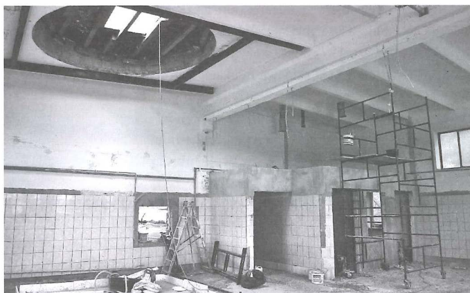
Modernizacja oczyszczalni ścieków w Kolbuszowej Dolnej
