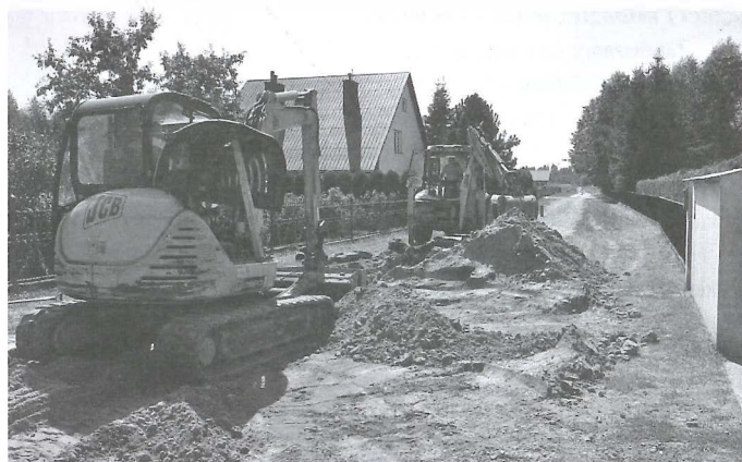
Roboty kanalizacyjne w Kolbuszowej Górnej
