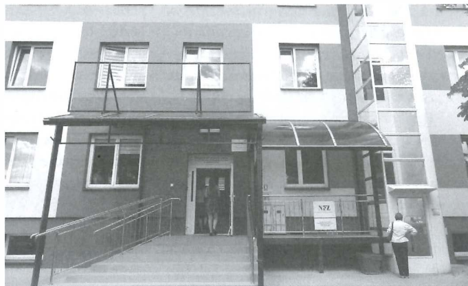
Przychodnia Rejonowa nr 1 w Kolbuszowej wraz z dobudowaną windą.
