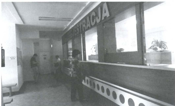
Nowo przebudowana rejestracja w Przychodni Rejonowej nr 1 w Kolbuszowej.
