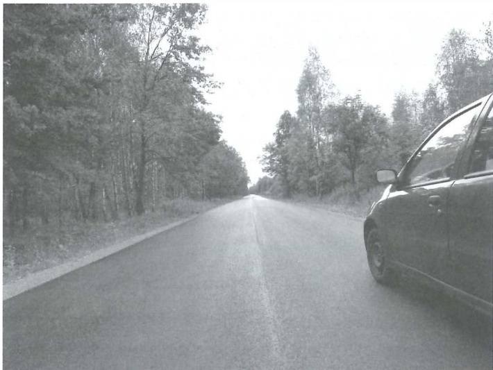
Odremontowana droga powiatowa relacji Kłapówka – Widelka.
