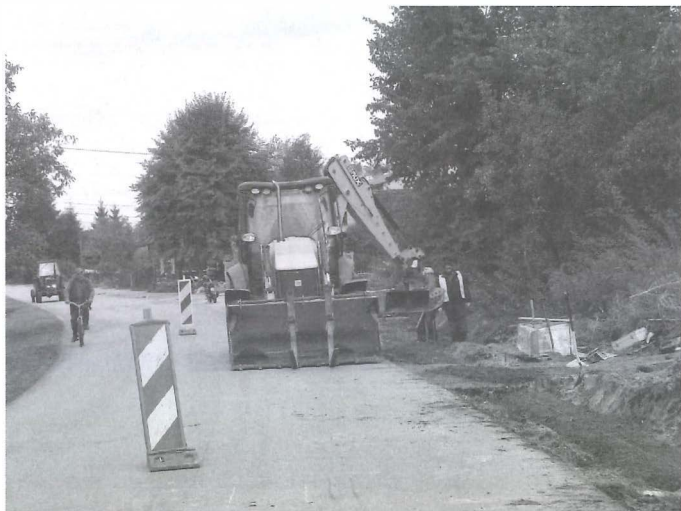
Prace przy budowie chodnika w Dzikowcu. Fot. B. Żarkowska
