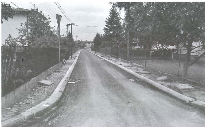
Końcowe prace na ul. Matejki
