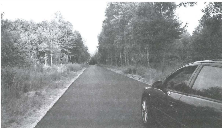
Żwirową nawierzchnię na drodze powiatowej Lipnica-Poręby Dymarskie zastąpił nowy dywanik asfaltowy. Fot. B. Żarkowska
