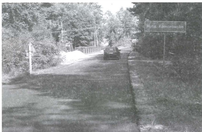
Remont drogi powiatowej Komorów – Huta Komorowska – Konięcpól.
