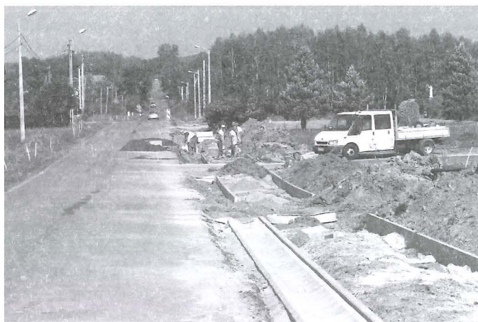
Budowa chodnika w Przyłęku.
