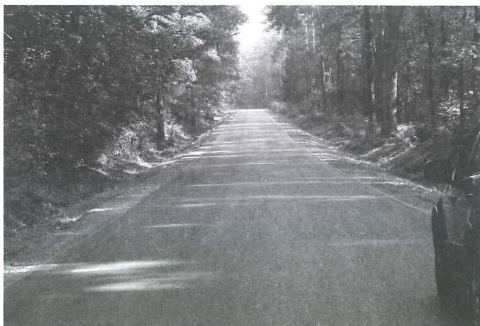
Odremontowana droga powiatowa łącząca Kolbuszowę z Niwiskami.
