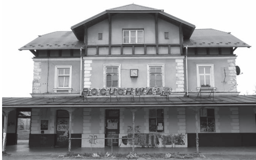
Ilustracja 3. Budynek stacji kolejowej w Boguchwale z lat dziewięćdziesiątych XIX w. Stan obecny.
