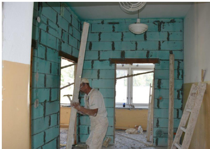
Remont budynku dawnej szkoły w Hucie Przedborskiej
