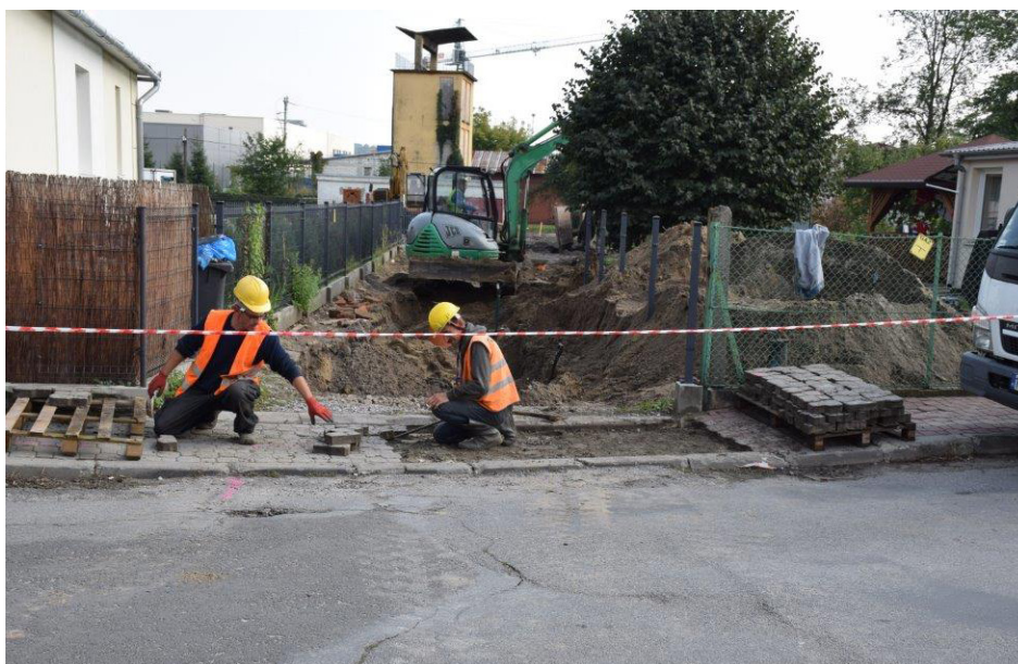
Trwają prace przy budowie kanalizacji
