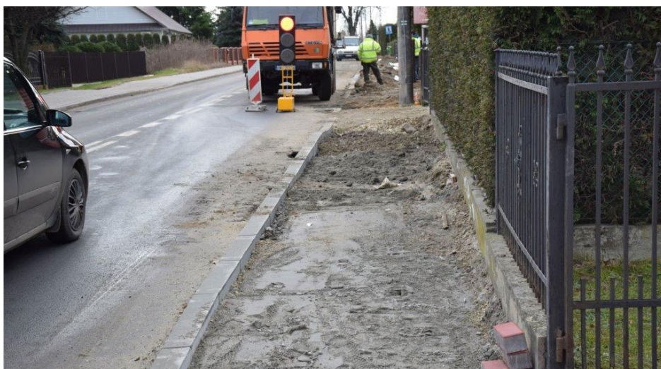
Przebudowa kanalizacji deszczowej wzdłuż ul. Piłsudskiego, fot. A. Selwa
