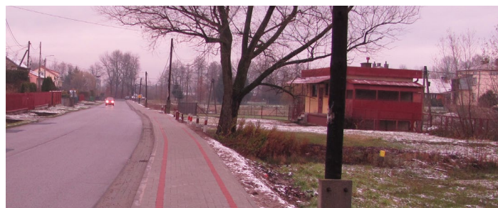
Zakończono przebudowę drogi powiatowej Nr 1209 R Zielonka - Korcówiska
