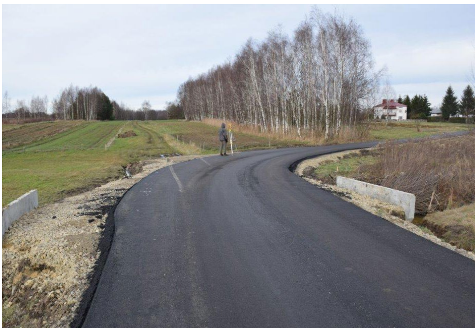
Końcowe prace przy przebudowie drogi Widelka - Majdan, foto. A.Selwa
