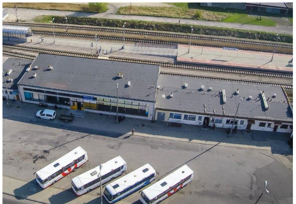
Zakupione działki na budowę parkingu przy stacji kolejowej
