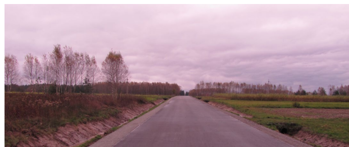
Zakończono prace przy budowie chodnika dla pieszych przy drodze powiatowej Nr 1213 Widelka - Hucisko
