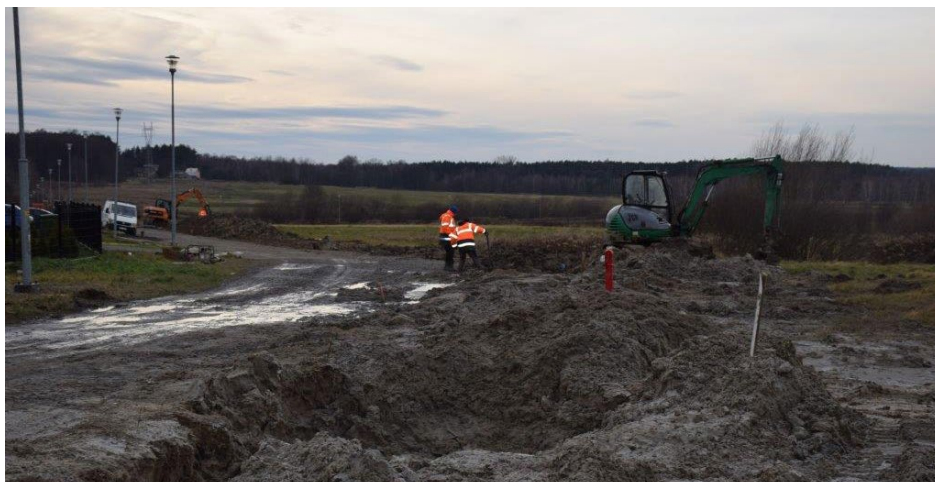
Budowa sieci wodociągowej i kanalizacyjnej w ul. Malwowej, fot. A. Selwa
