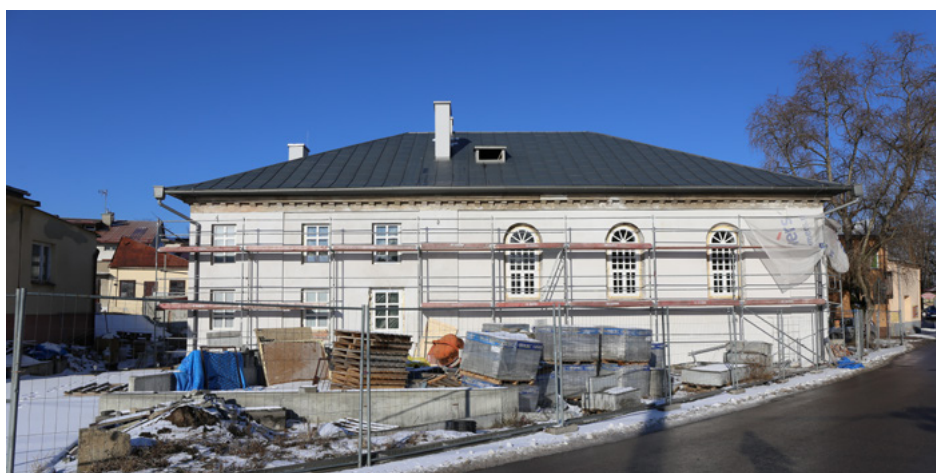
Coraz ładniejszy budynek dawnej synagogi
