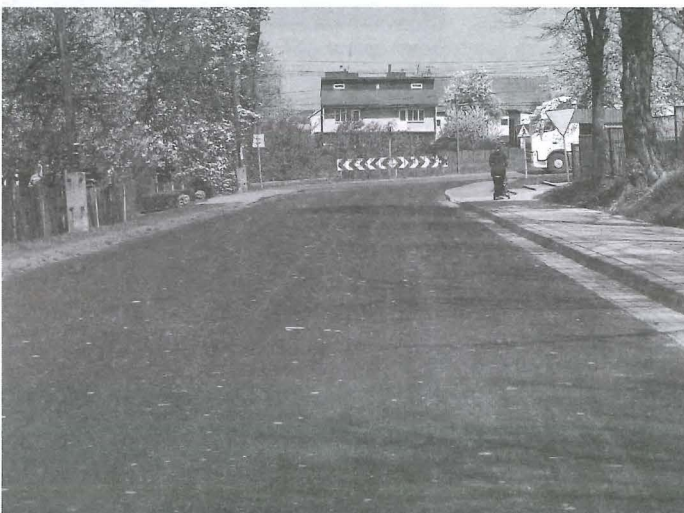
Droga powiatowa po remoncie w Lipnicy.
