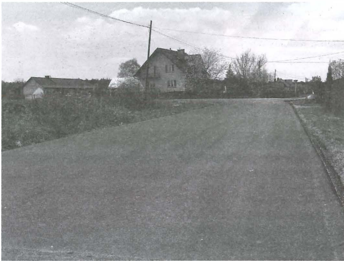
Zmodernizowana droga powiatowa w Trzęsówce. Fot. B. Żarkowska
