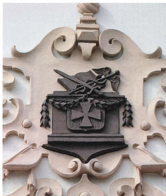
Fot. 65. Herb miasta Rzeszowa na ścianie frontowej ratusza. Tu też widoczne szrafowanie pionowe tarczy oznaczające barwę czerwoną. (Fot. B. Popek, 2014 r.)
