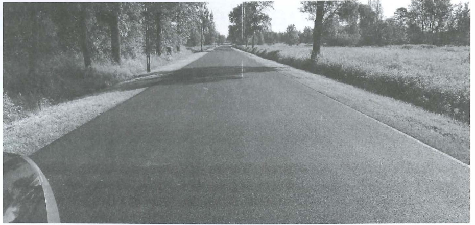
Nowy dywanik asfaltowy na drodze powiatowej Lipnica-Dzikowiec. Fot. B. Żarkowska
