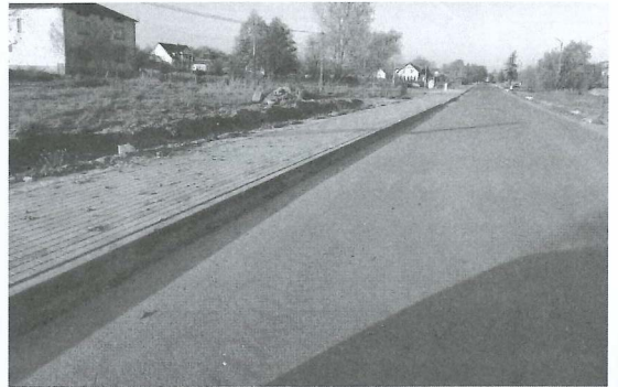
Oprócz modernizacji nawierzchni budowane są także nowe odcinki chodników
