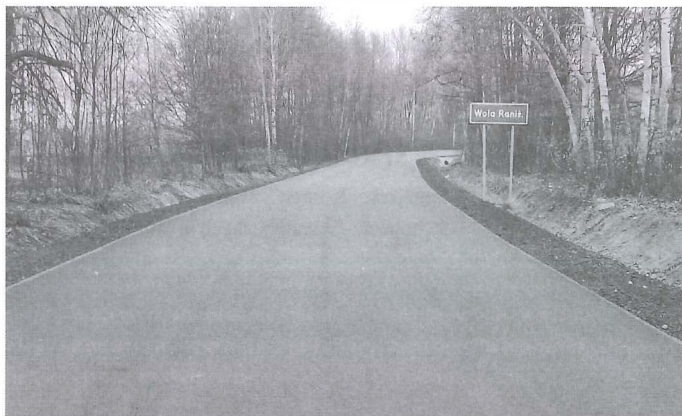
Nowo odremontowana droga powiatowa
