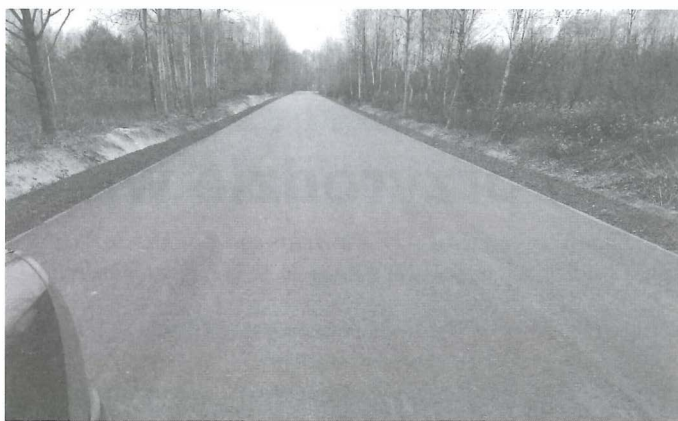
W Woli Raniżowskiej droga powiatowa przebudowana została na długości ponad trzech kilometrów Fot. B. Żarkowska
