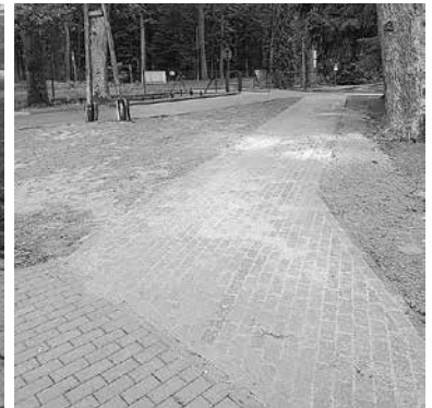
Wymiana nawierzchni polegała na zerwaniu starych płyt chodnikowych i położeniu nowej kostki brukowej
