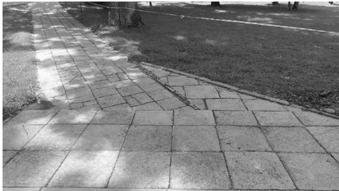
Wymiana nawierzchni polegała na zerwaniu starych płyt chodnikowych i położeniu nowej kostki brukowej
