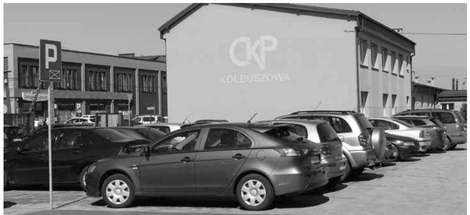
Nowo przebudowany parking przy Zespole Szkół Technicznych w Kolbuszowej. Fot. B. Żarkowska
