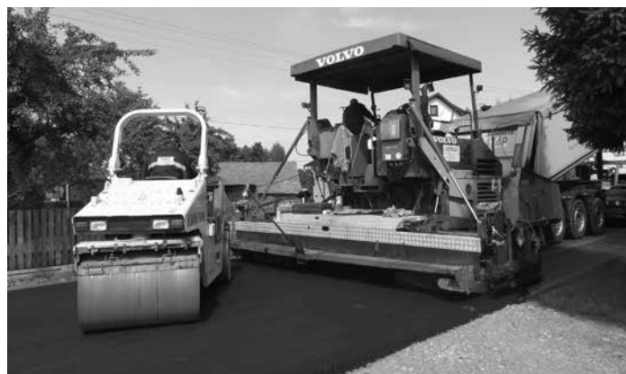
Intensywne prace trwają
