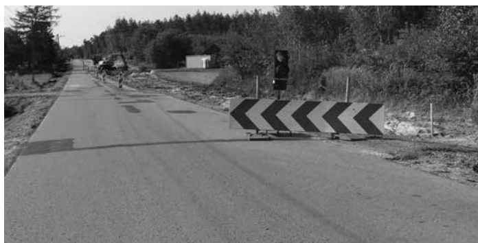
W Komorowie trwa przebudowa drogi powiatowej. Fot. B. Żarkowska
