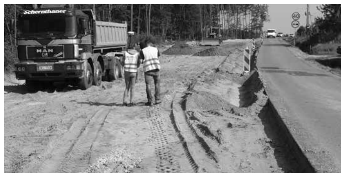
W ramach inwestycji wykonywanych jest szereg prac
