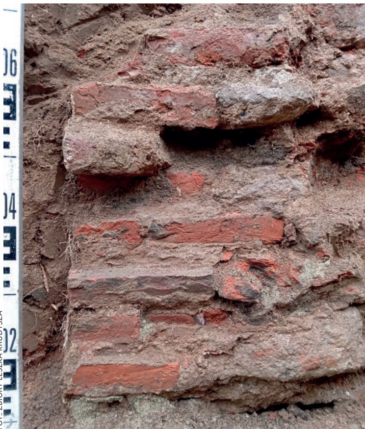
FOT.10. MUR V, ZBLIŻENIE UKAZUJĄCE CEGLANY WĄTEK MURU
