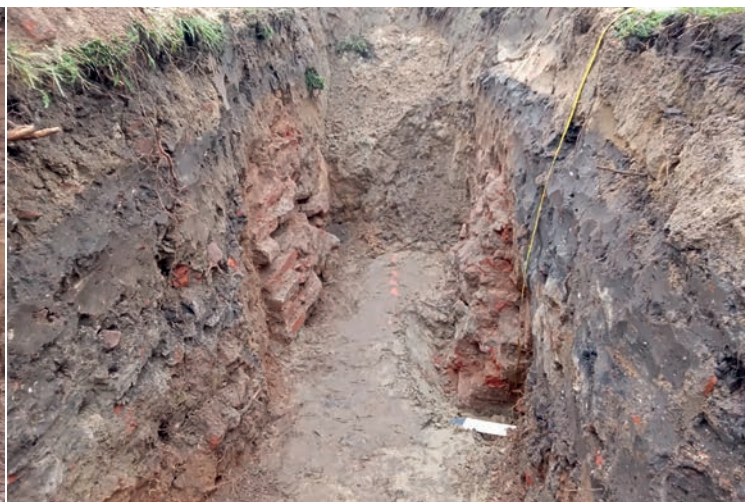
FOT.12. MUR V ROZERWANY W TRAKCIE INSTALACJI RURY KANAŁIZACYJNEJ.
